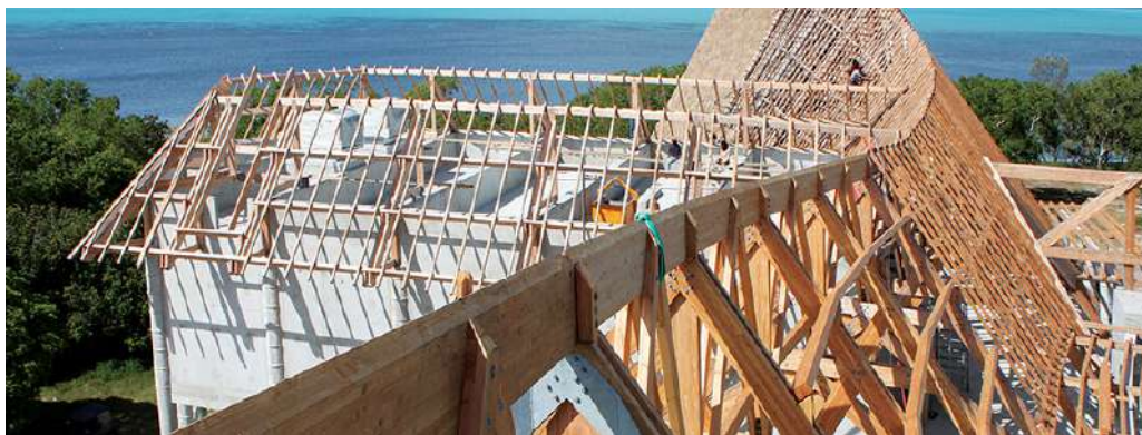
Sheraton Lift, Bâtiment Concept NC
